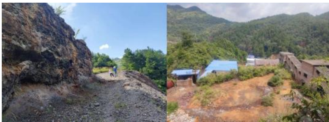
图 3-1 项目废渣堆现状
