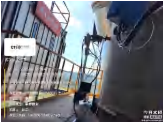
附 1：现场采样照片 2#窑尾烟囱（DA003）出口
