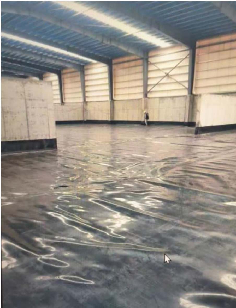
图 10.3-1 现状原料库防渗施工图
