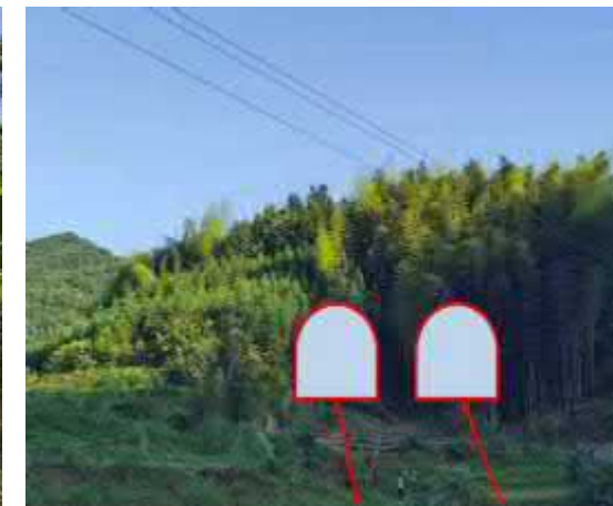
紫金山 3 号道县端洞口
