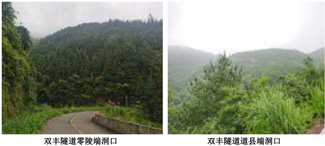
图 2.6-12 隧道进出口现状照片
