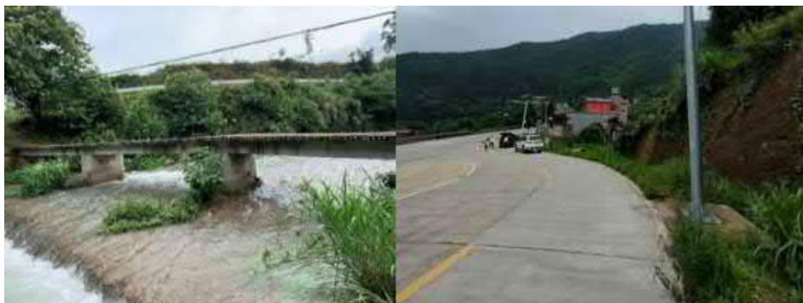
图 2.6-5 打鼓坪 2 号大桥桥址区实景图
