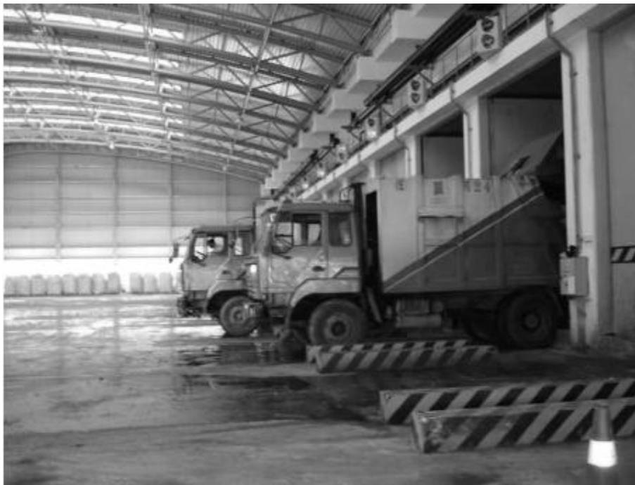
图 3.4-2 垃圾卸料大厅
