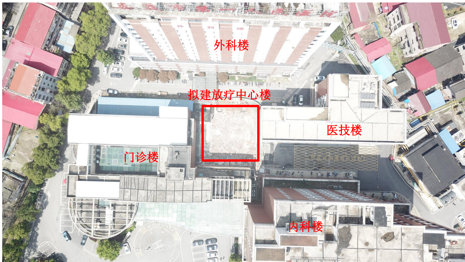
附图 9-1 现场照片（航拍）
