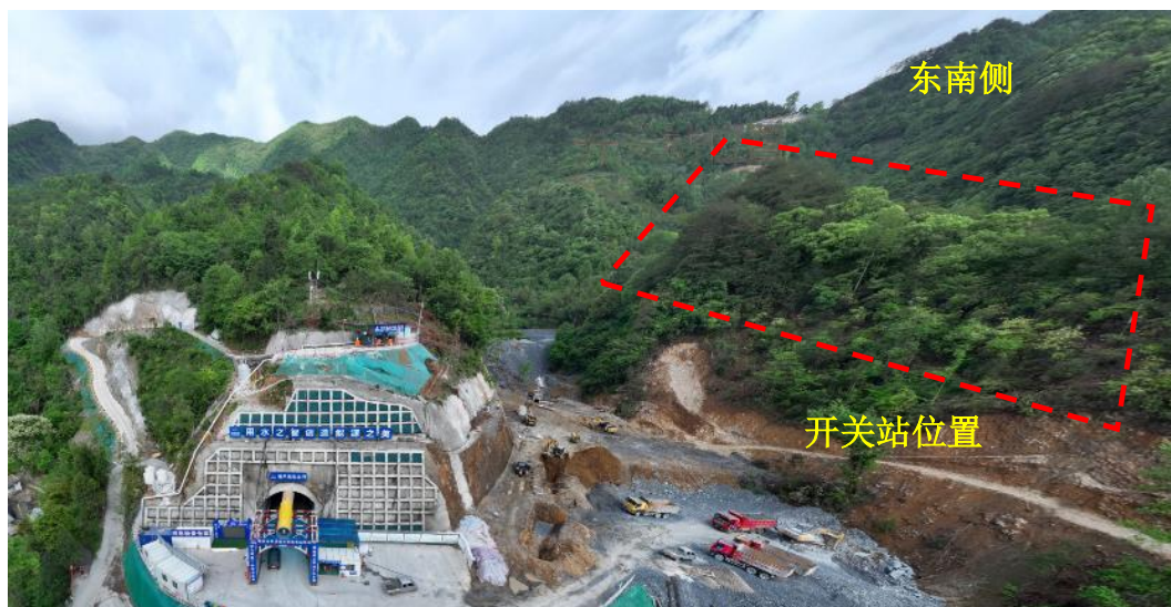
开关站及周边现状
