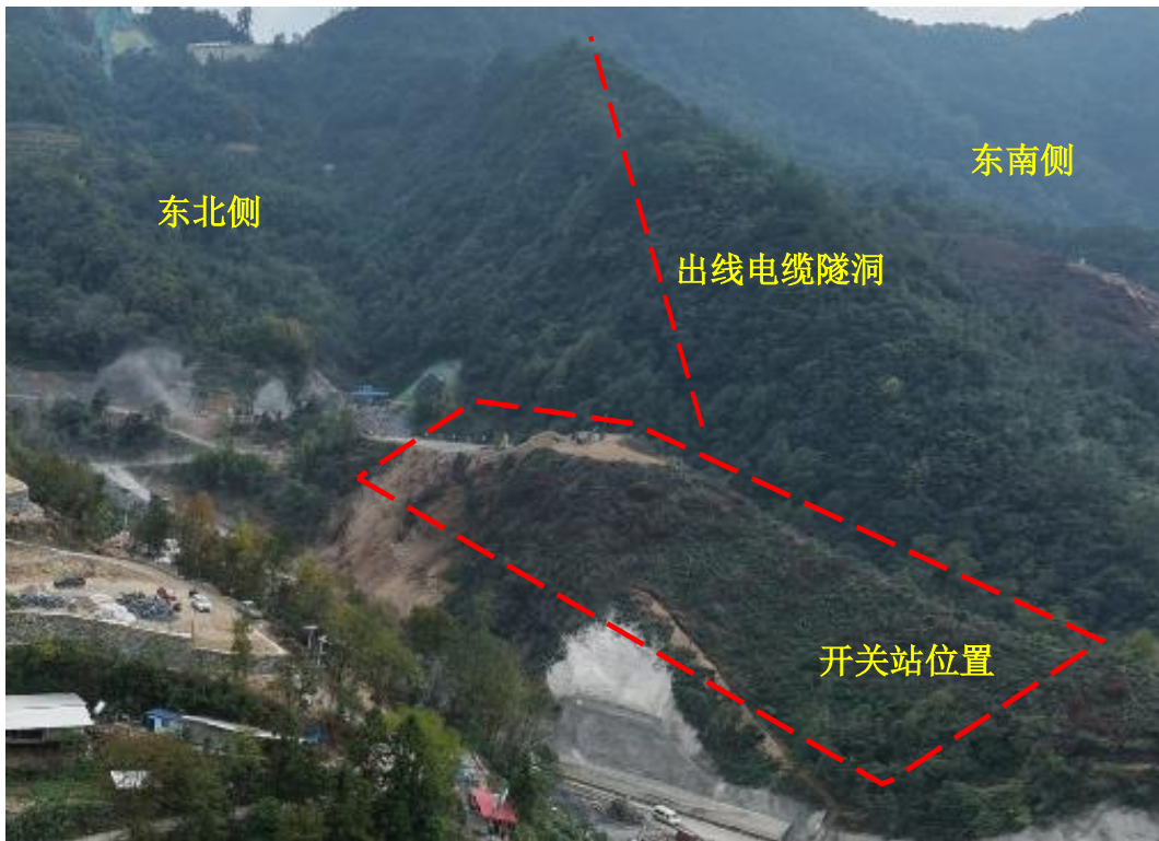
开关站、出线电缆隧洞现状及周边
