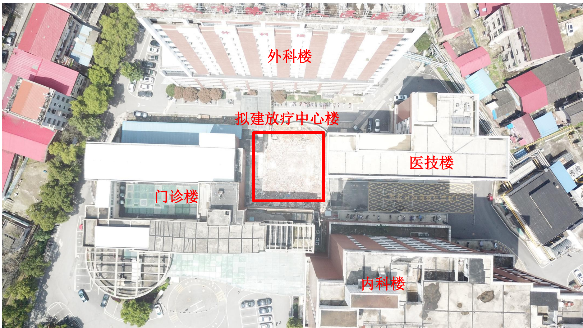
附图 8-1 现场照片（航拍）
