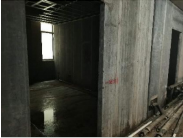
门诊楼 1 层 急诊 DSA
