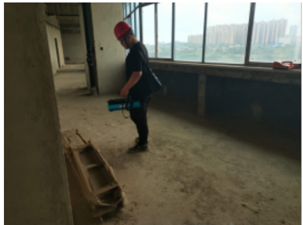
门诊住院楼 4 层 北侧 DSA 复合手术室
