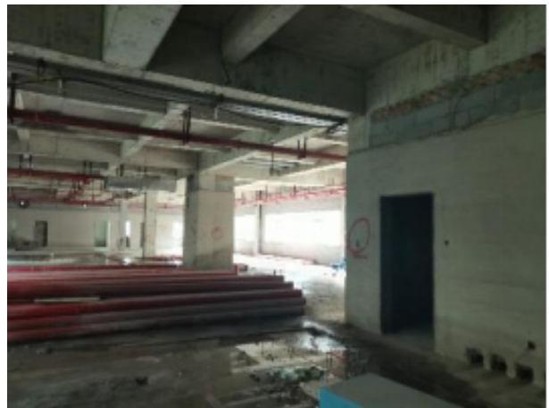
门诊楼 5 层 手术部 DSA 杂交手术室
