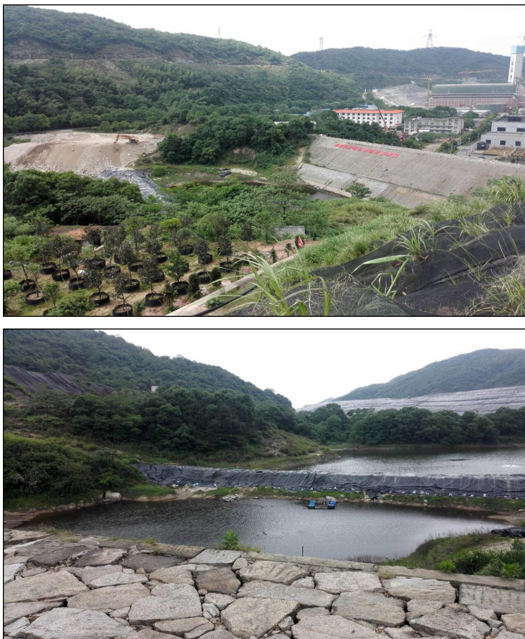
图 6.4-1 项目拟建厂址现场照片
