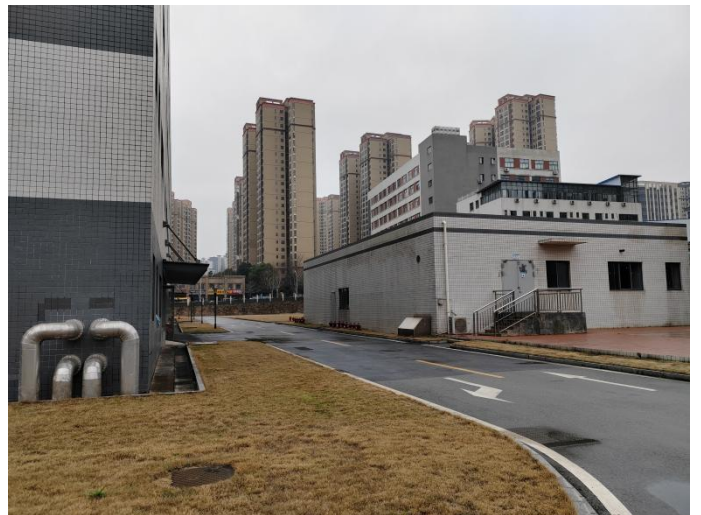
1#厂房北侧道路及设备房
