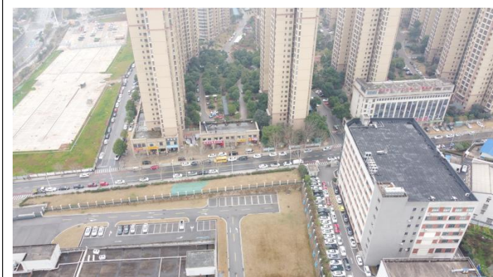
1#厂房西侧道路及城市道路
