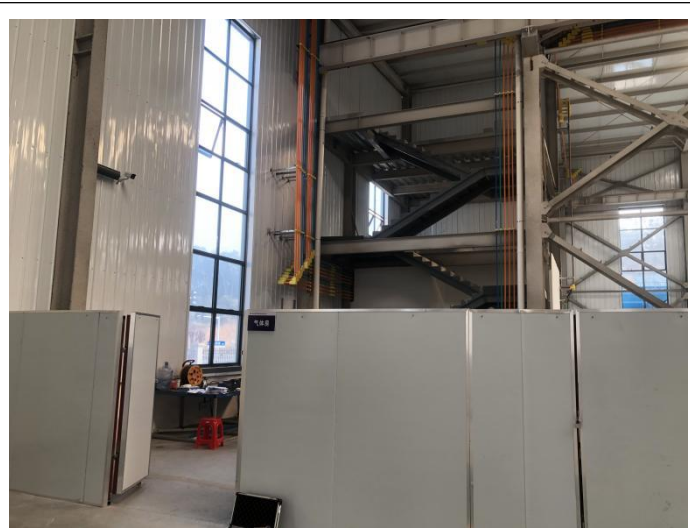
拟建区域西侧气体库
