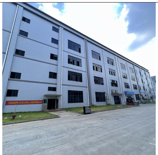
五厂南侧食堂
