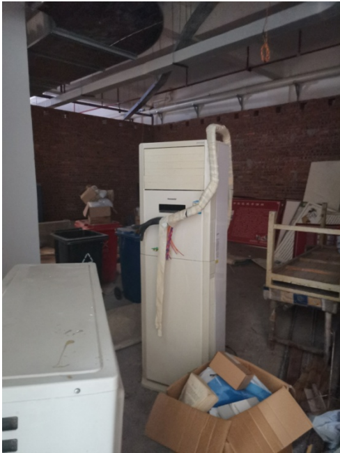
拟建 DSA 机房现状闲置房间
