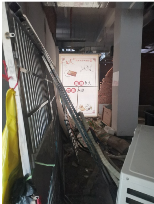
拟建 DSA 机房西侧现状闲置房间
