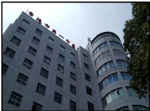
项目所在大楼
