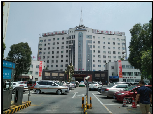
项目所在大楼
