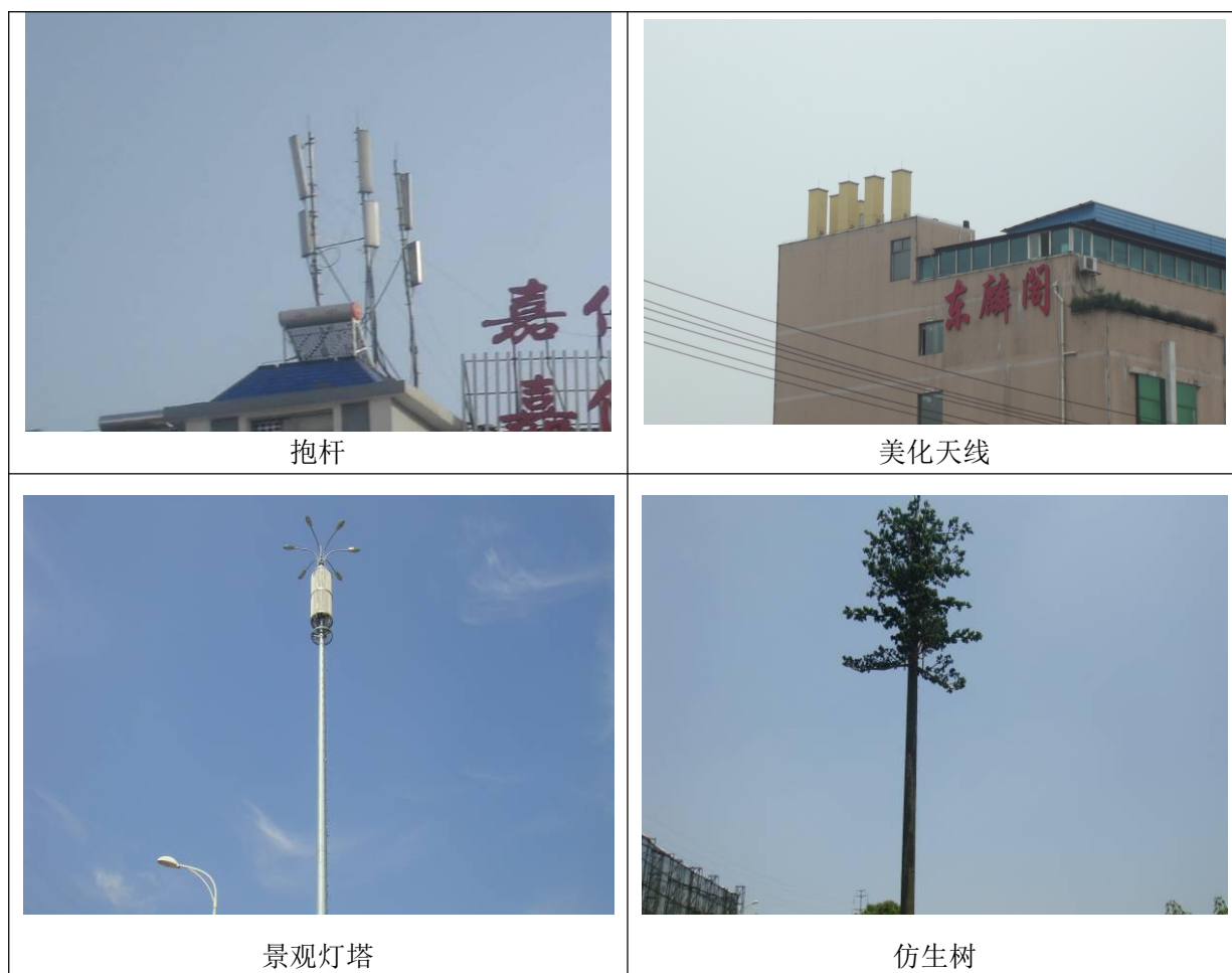
图 3-9 天线架设方式
