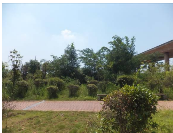
天心区黑石铺大桥东
