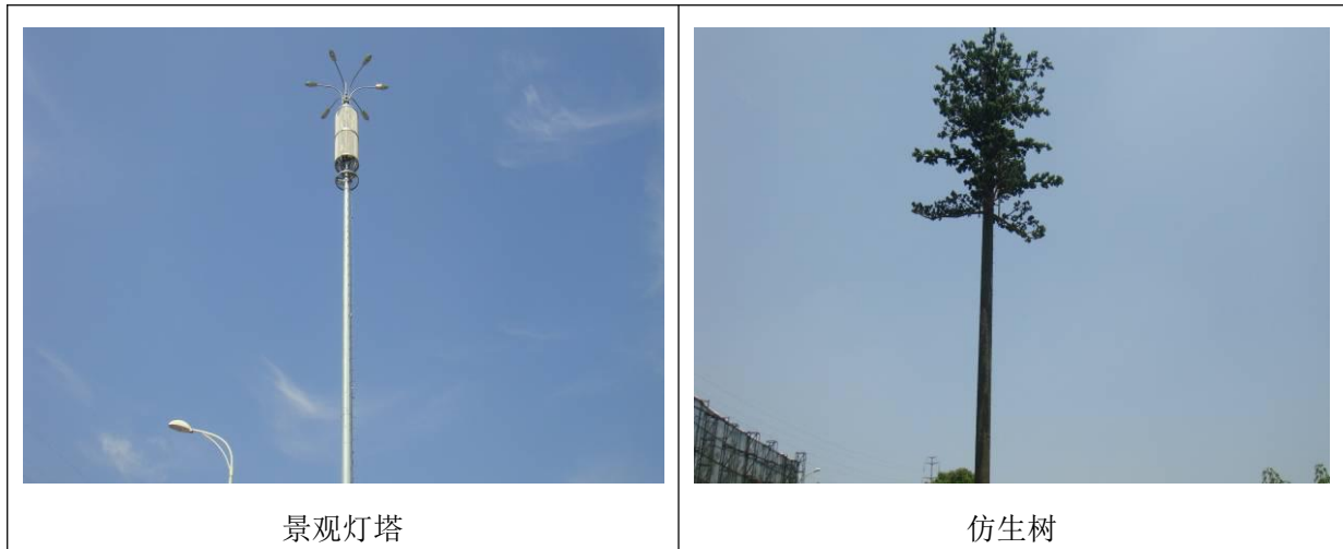
图 3-8 天线架设方式
