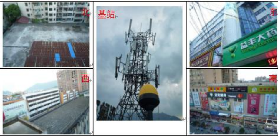
图 6-3-2 洞口县供销大厦基站周边环境照片
