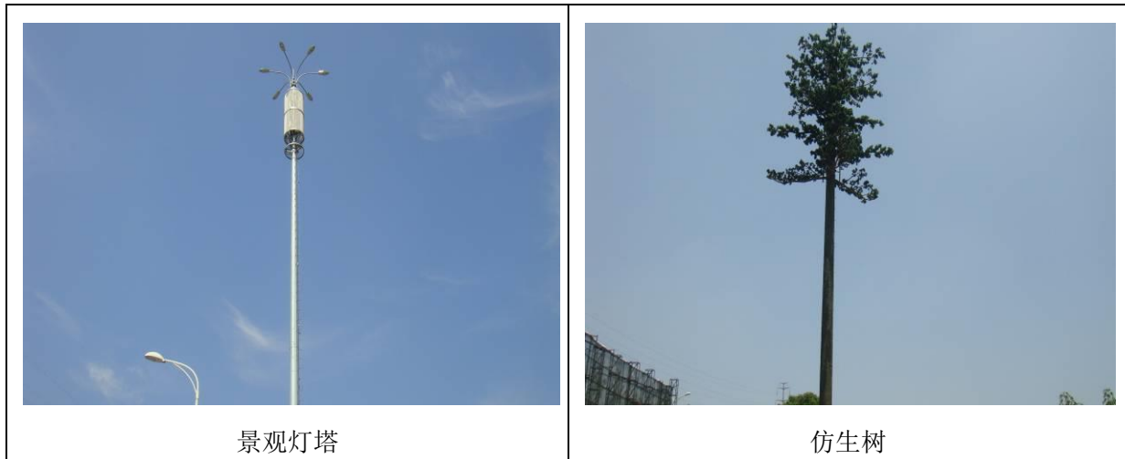
图 3-9 天线架设方式
