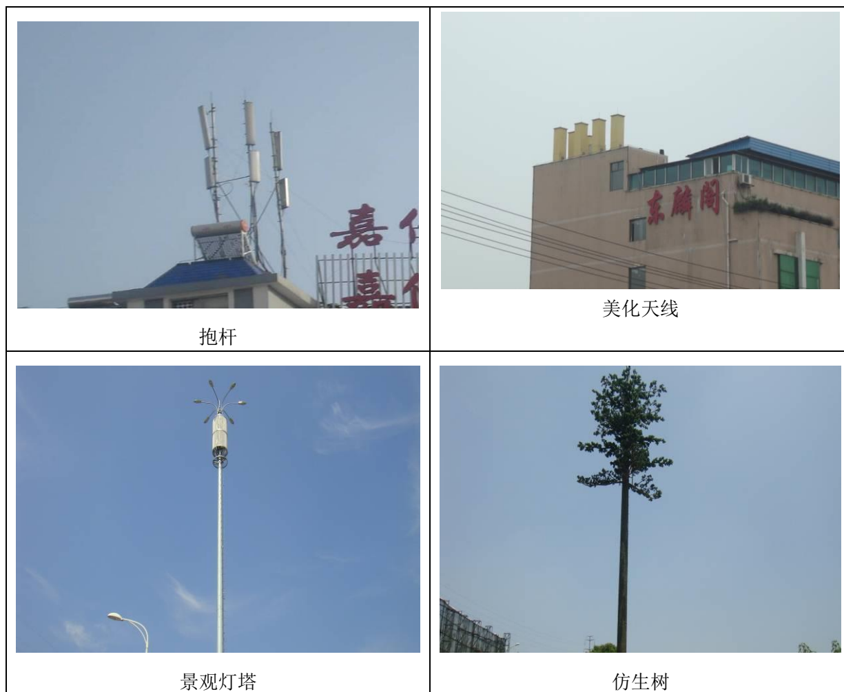
图 3-8 天线架设方式
