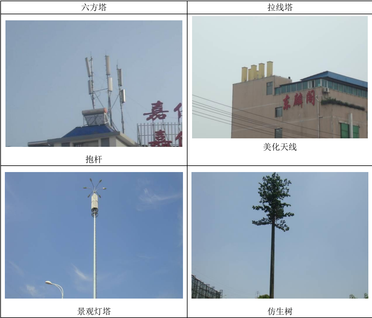
图 3-8 天线架设方式
