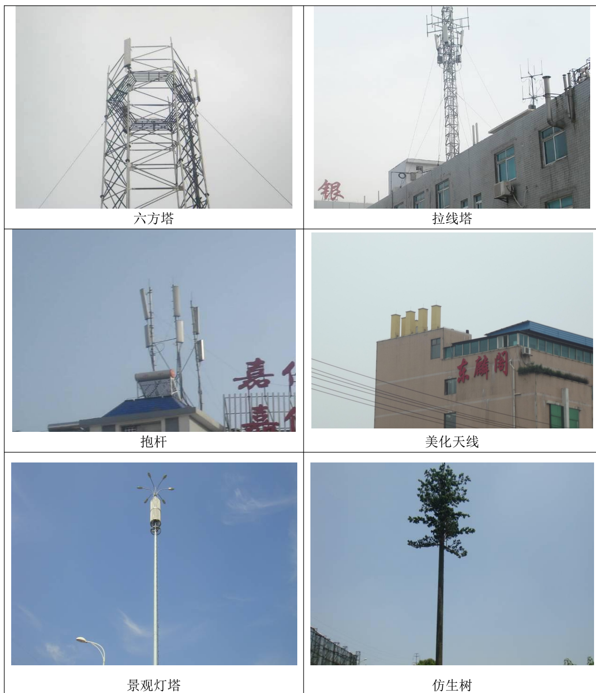
图 3-9 天线架设方式
