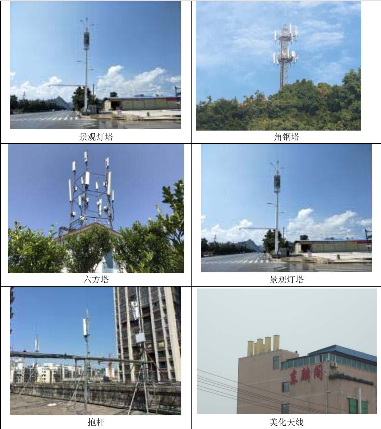
图 3-9 天线架设方式
