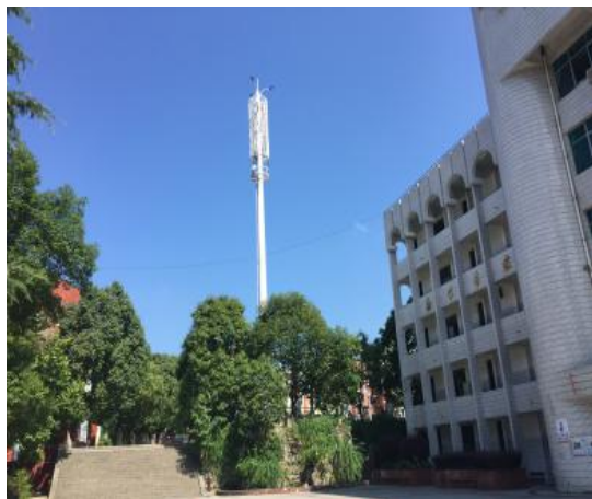
LFH-永顺县金谷子酒店-拉-一中铁塔
