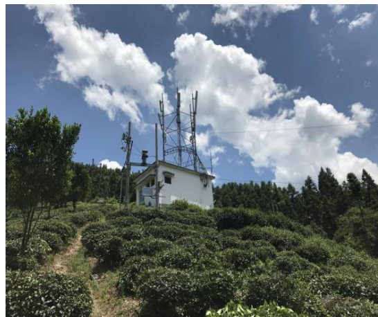
LFH-古丈县邮政局-拉-三道河
