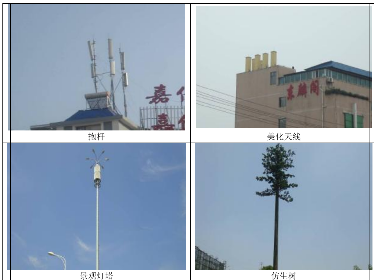
图 5-8 天线架设方式
