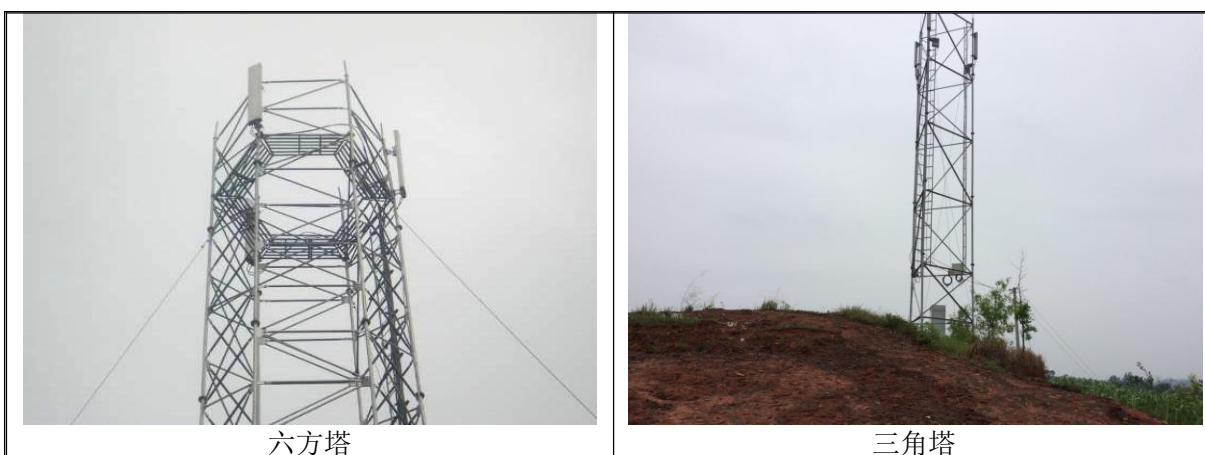
图 5-9 天线架设方式
