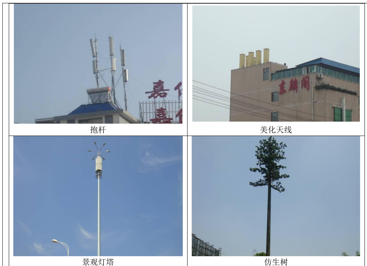
图 5-8 天线架设方式
