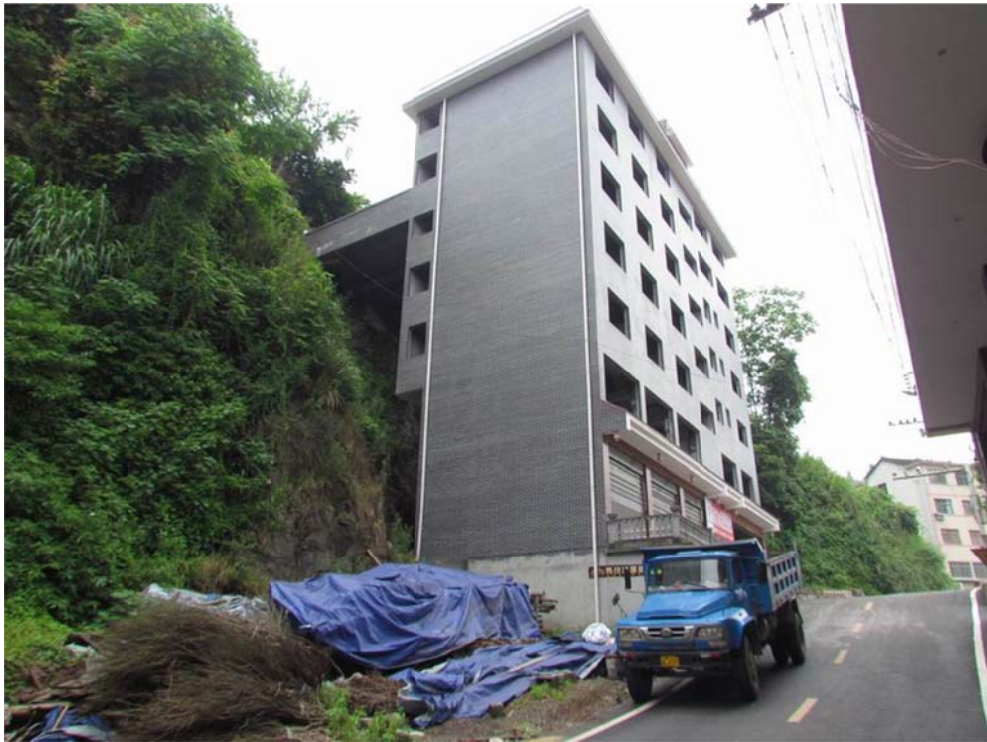
图 3 湖南湘西古丈城南 110kV 变电站站址北侧民房
