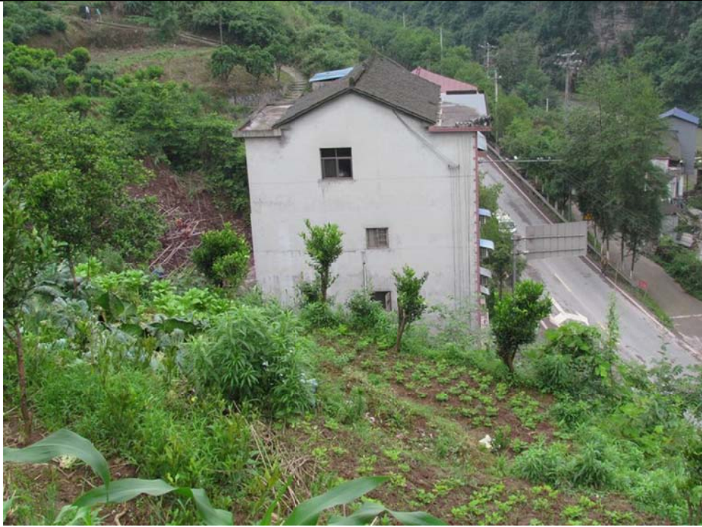
图 2 湖南湘西古丈城南 110kV 变电站站址西北侧民房
