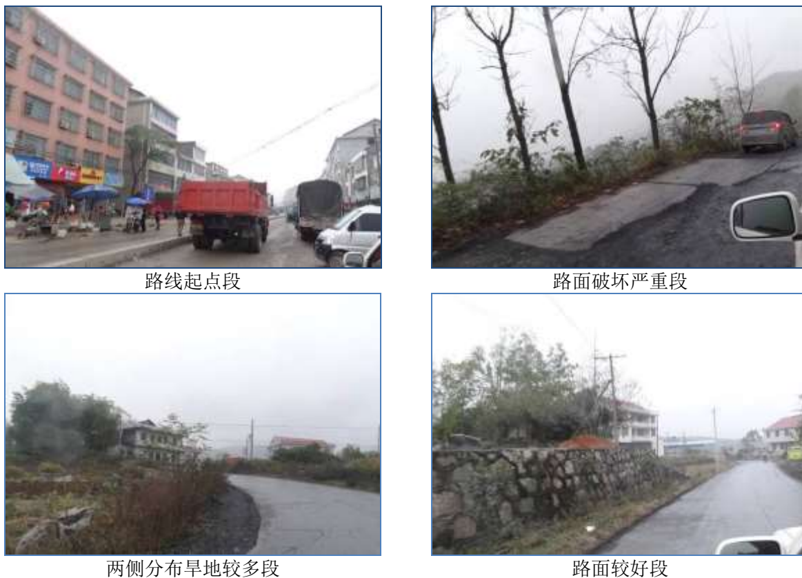
图 2.2-2 起点（温塘镇）至戴家湾段路段现状照片
