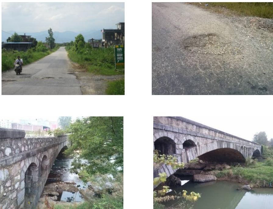
图 2-1 现有公路及桥梁现状
