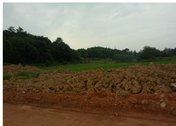
土方沿线两侧堆放
