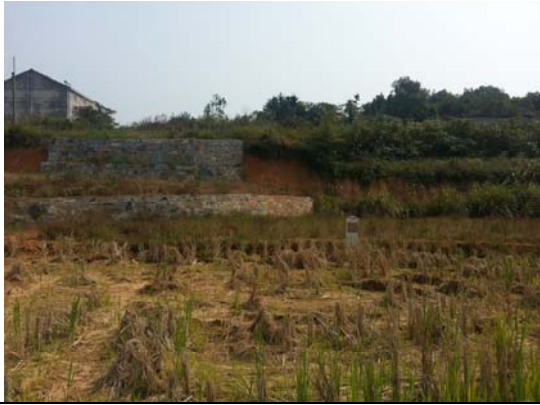
管线施工生态恢复 1
