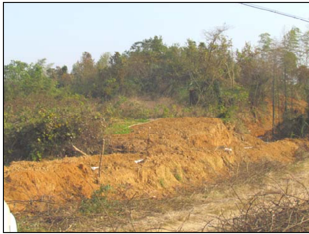
取土场现场照片
