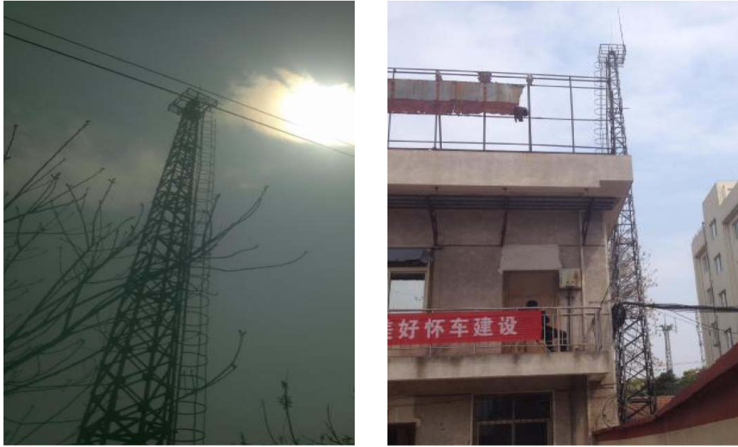
图 5-9 天线架设方式
