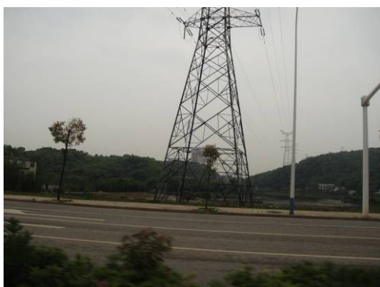
望江路沿线高压线
