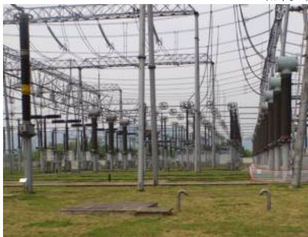
事故油池现状
