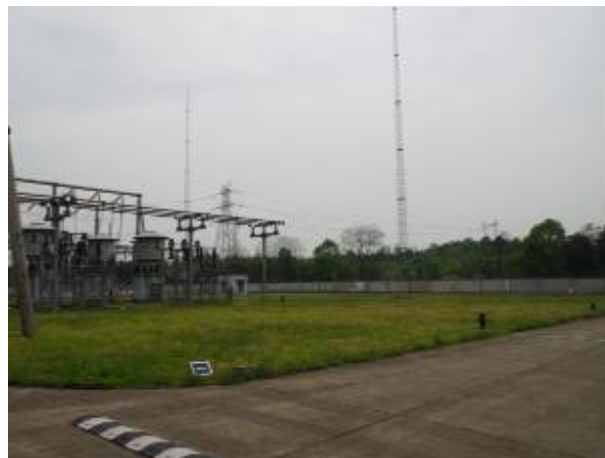
站区内部绿化现状
