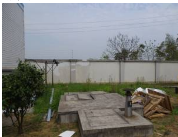
地埋式生活污水处理设施现状
