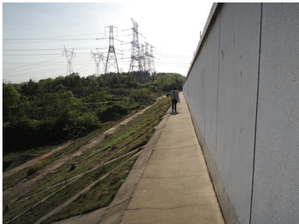
站区围墙外植被现状
