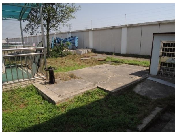
地埋式生活污水处理设施现状
