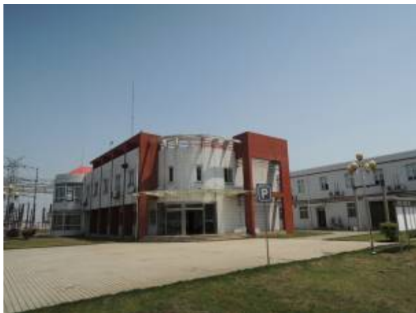
长阳铺变电站主控楼
