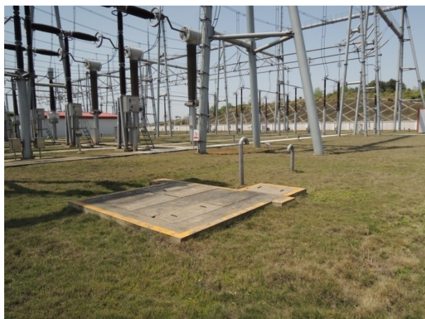
主变事故油池
