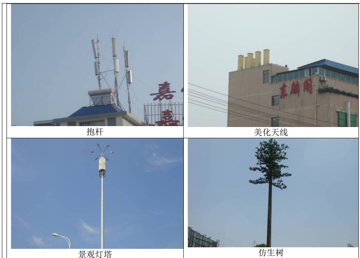
图 5-8 天线架设方式
