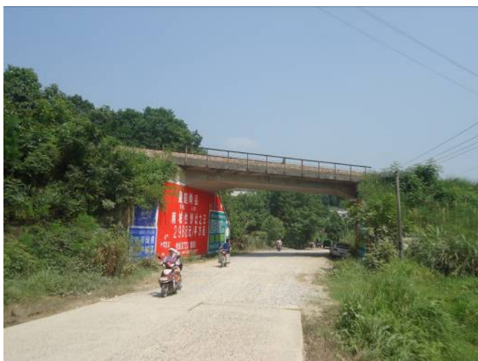
图 2-2 本项目下穿铁路现有涵洞
