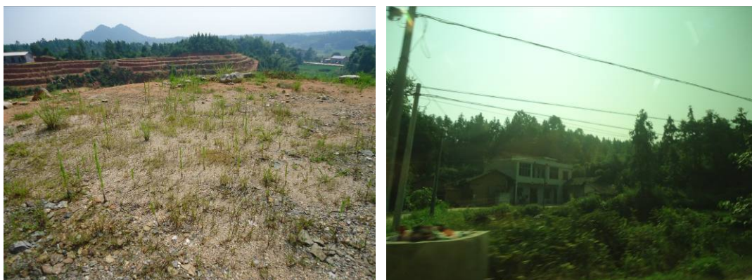
图 2-5 施工场地现状图
