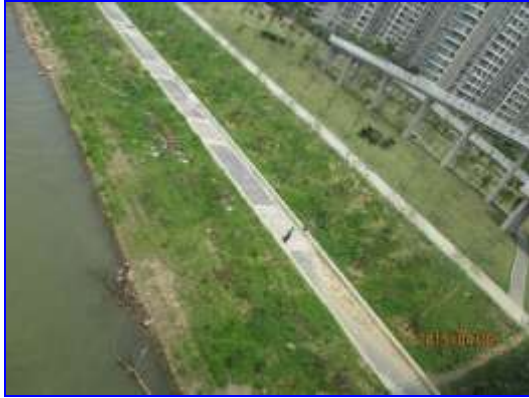
东岸施工道路区现状
