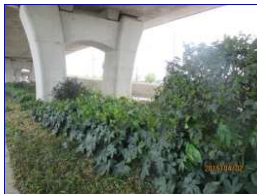
高架桥下平整及地表覆草植被
