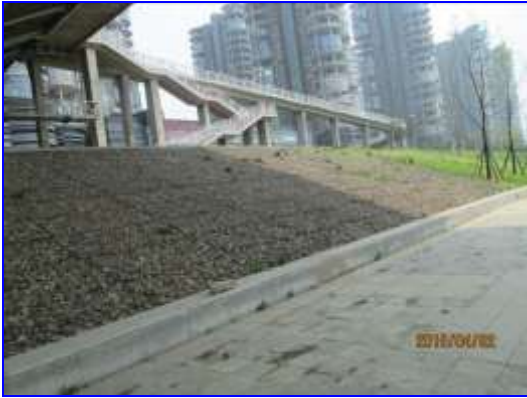
主桥东岸桥头边坡防护
