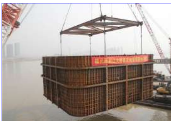
施工期围堰整体下放
