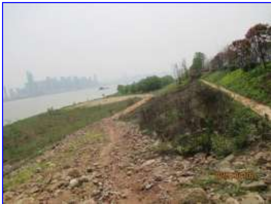
西岸施工保留道路区现状
