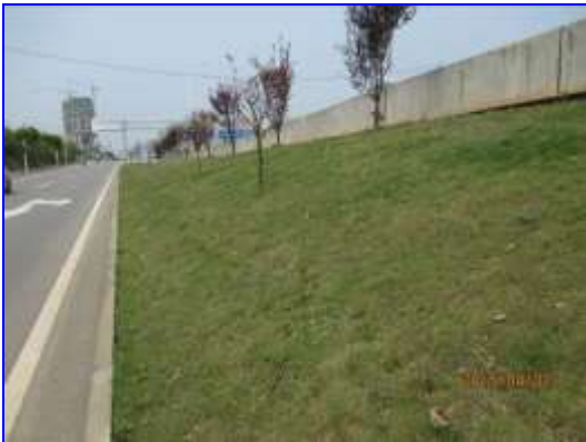
西岸引桥边坡防护
