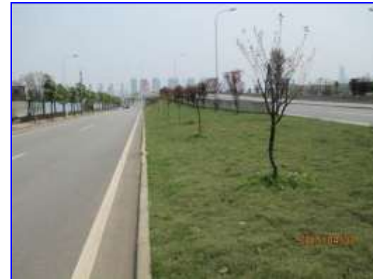
西岸引桥边坡防护
