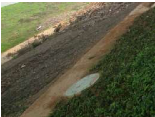
主桥西岸桥头边坡防护
