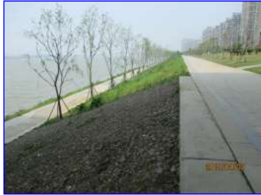
主桥东岸桥头岸边护坡植被
