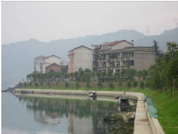
黄沙坪抬填区库岸防护
