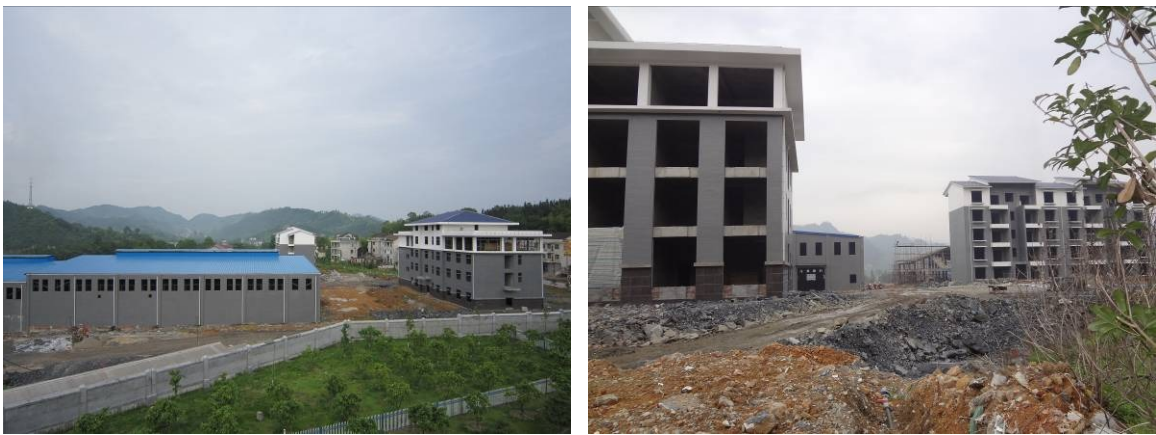
大坝右岸下游施工营地现状
