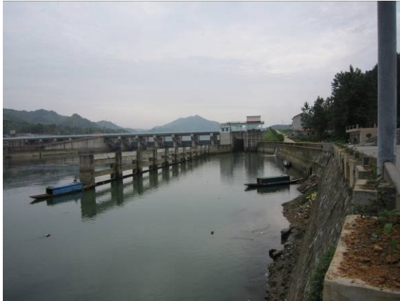
船闸出口挡墙
