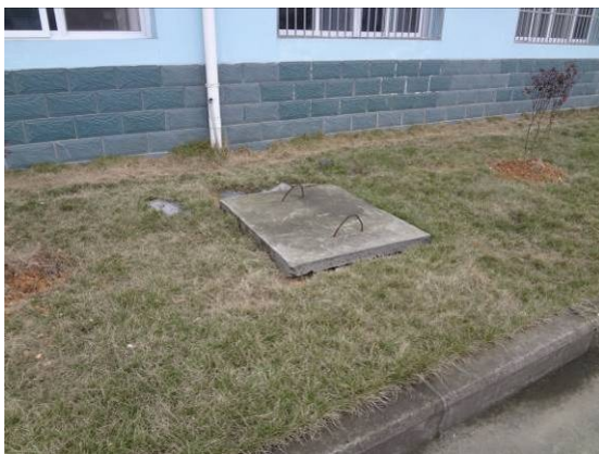
电站办公生活区化粪池
