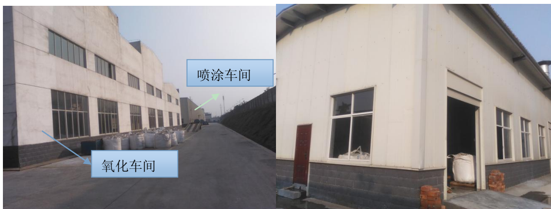
喷涂车间及氧化车间
