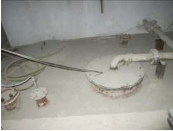
垃圾渗滤液收集坑（地下）
