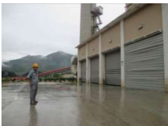
垃圾卸料平台外景
