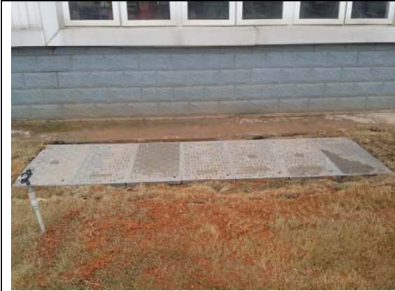
新厂区焊接车间新增废水处理池
