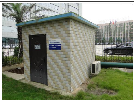
废水在线机房
