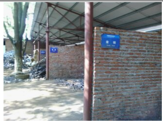
一般固废暂存场所
