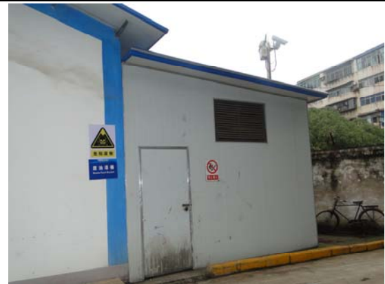
废油漆渣、废油漆桶暂存处
