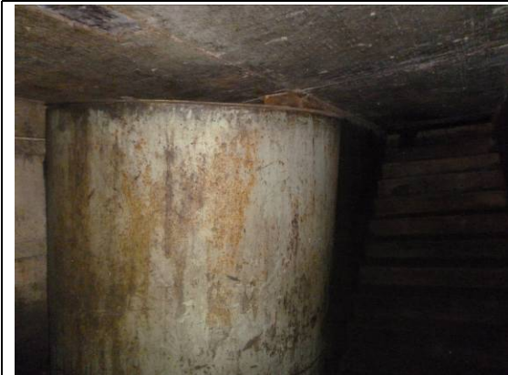
含油废水处理污泥暂存场所
