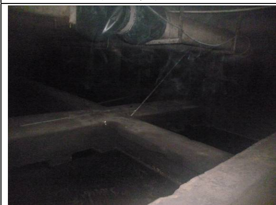
生产废水及雨水总排口
