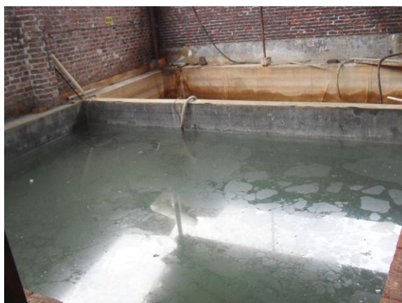
琼花公司废水处理池
