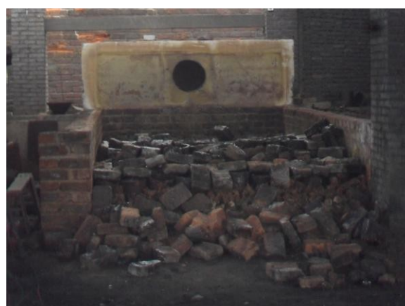
振鑫公司已拆除的煮炉
