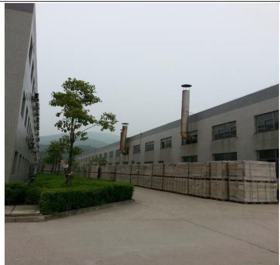
套管分厂抽屉窑排气筒
