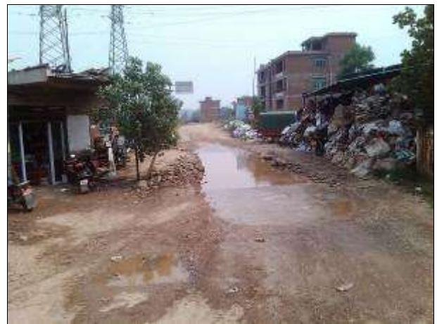
B 排水系统不连贯、不完整
