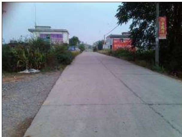
C 按通村公路建成的水泥砼路面
