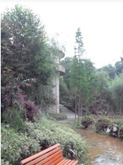
工业街水厂取水泵房
