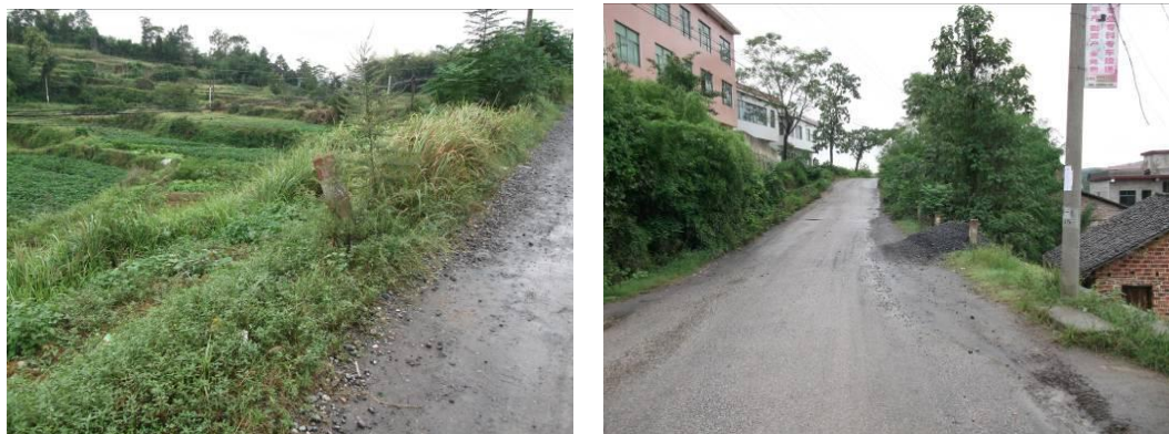
图 3-3 原有局部防护设施情况
