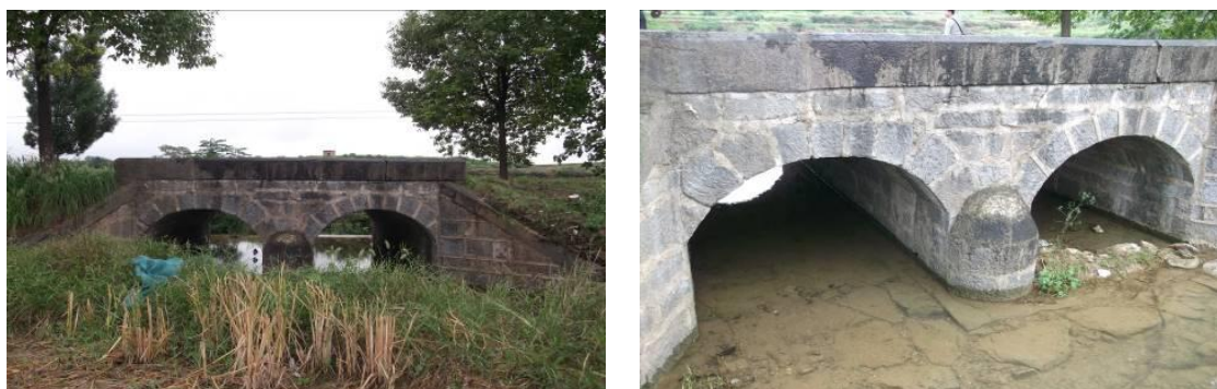
图 3-2 现有面铺小桥照片
