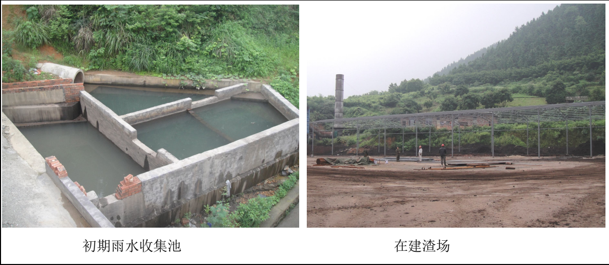
图 5-1 初期雨水池和在建渣场
