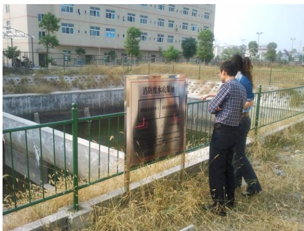
Ht-13 消防水收集池
