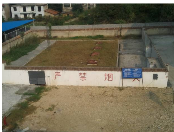
Ht-11 甲醇及二甲苯储罐区
