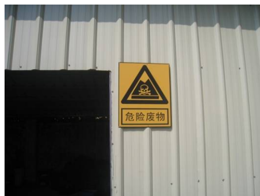
Gd-16 危险废物暂存场所 1
