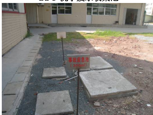
Gd-3 事故应急池
