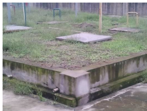
K11-14 甲醇及二甲苯储罐区围堰
