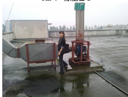
KII-6 乳油车间废气活性炭吸附处理装置
