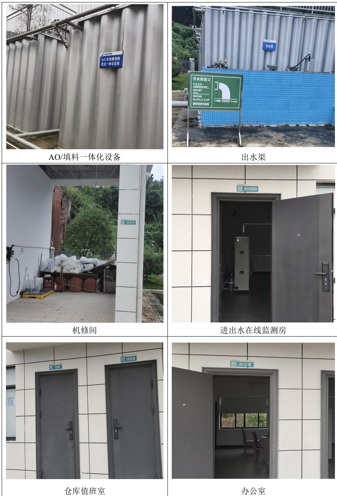
图 3.3-1 五强溪镇北污水处理厂现状图
