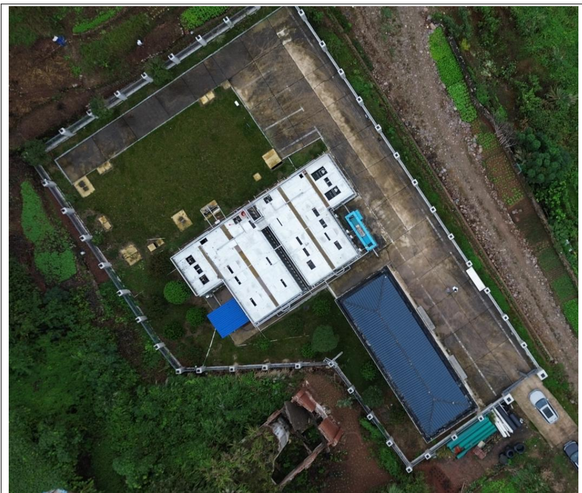
五强溪镇北污水处理厂全景
